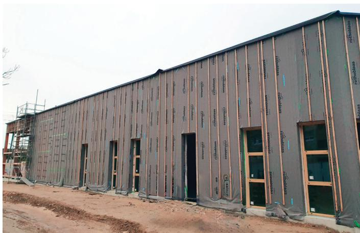
Façade à ossature bois-paille d'une extension d'usine L'Oréal SICOS dans le Nord (3500 m<sup>2</sup>) pour le stockage et le laboratoire R&D Un bâtiment à énergie positive (Architecte-urbaniste : Jean Luc Collet).
